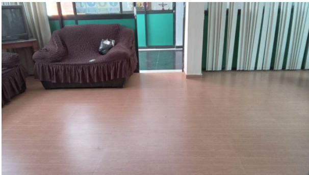
Fotografía No. 9. Vista del cambio de piso terminado en ambiente de Sala de Recepción (costado derecho entrando).
