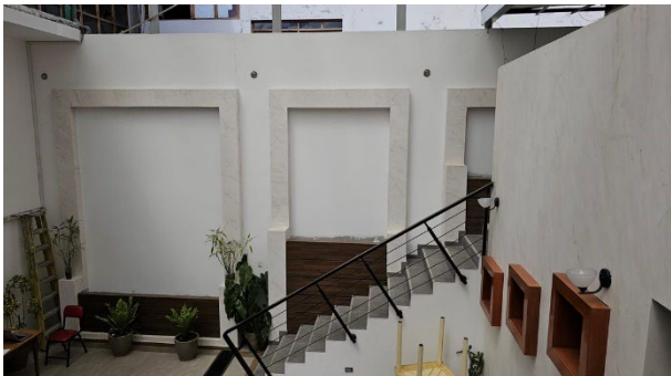
Fotografía No. 13. Vista del muro de ladrillo con columnas y vigas de amarre en reemplazo del antiguo muro de drywall (muro colindante con la fiscalía), con jardineras y arcos de ladrillo.
