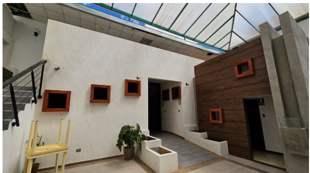
Fotografía No. 12. Vista de la fachada del auditorio con acabado pintura estucado veneciano, rampa de acceso, jardineras decorativas y fachada de baños.
