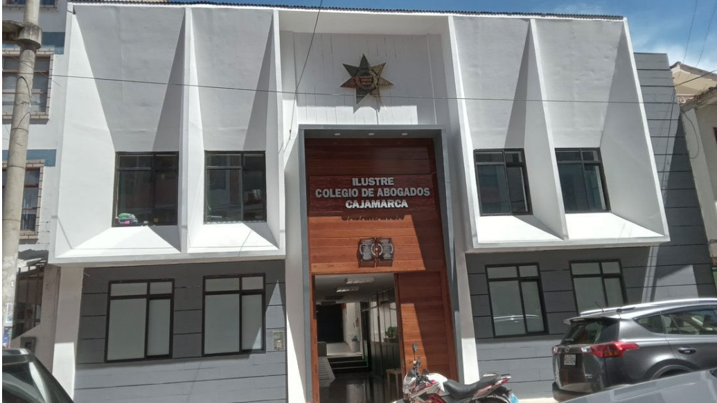
Fachada del Local Institucional del Ilustre Colegio de Abogados de Cajamarca, que es parte de la obra "Remodelación Casa del Abogado"
