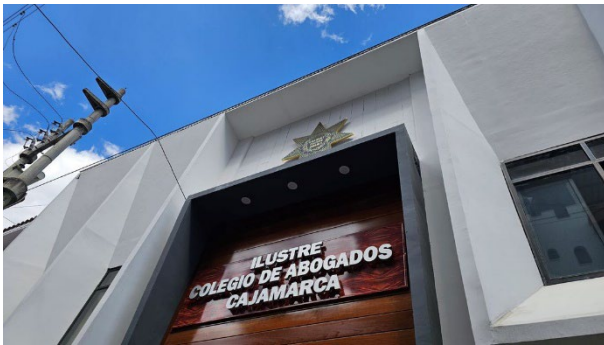
Fotografía No. 3. Luminarias LED Philips colocadas sobre portón de ingreso.
