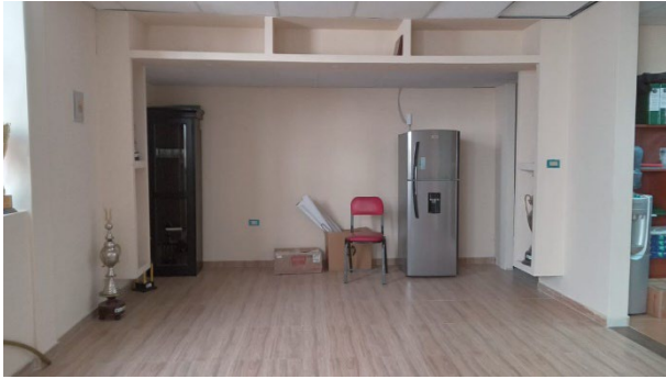
Fotografía No. 7. Mueble fabricado con drywall, con luminarias led marca Philips y falso cielo inferior; y cambio de piso.
