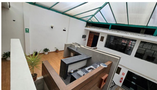
Fotografía No. 46. Vista del Cafetín, modificado respecto a la propuesta, con muebles de concreto, donde también se aprecia el denominado "muro especial" que sirve como cascada.
