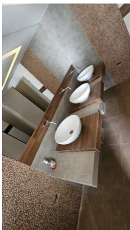
Fotografía No. 25. Vista interior del Baño de Mujeres, donde se aprecia ovalines marca Vainsa con grifería marca Trébol sobre mesa de concreto enchapada con porcelanato.
