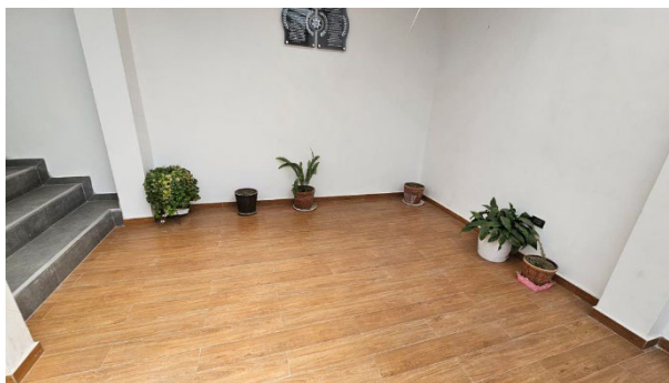
Fotografía No. 50. Cambio de piso en hall entre cafetín y acceso a Mezanine de Auditorio.
